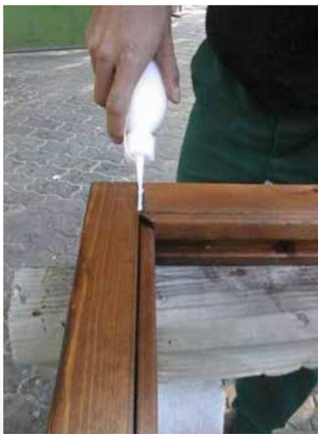
Fig. 7: applicazione dello stucco monocomponente XA 481 sulle teste. Dapprima si deposita con l'apposito dosatore sul legno di testa, quindi si toglie l'eccesso con un dito.
