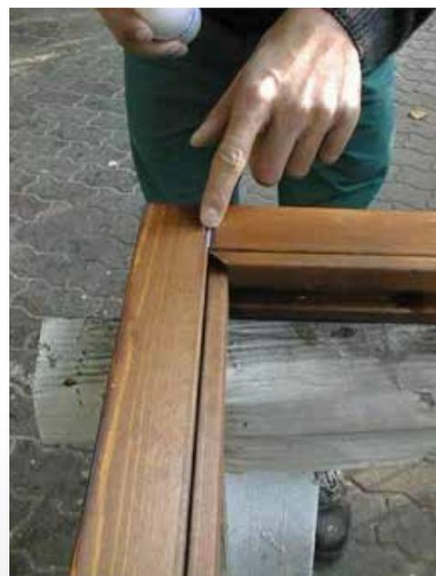
**Evitare che il montante del telaio fisso, nella parte esterna, arrivi fino alla base dell'infisso (cioè si appoggi al davanzale), adottando un traverso lungo quanto la larghezza del serramento.**
